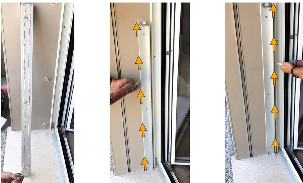
5. Une fois, les profils latéraux installés et étanchéifier avec le silicone (attendre 24 ou 48h de sèche). Vous pouvez installer le panneau du batardeau **(E)** pour vérifier que celui-ci s'installe correctement et facilement. Veillez à respecter le sens intérieur/extérieur indiquée sur le batardeau.
